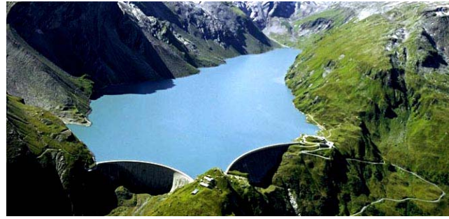
Speicherkraftwerk Kaprun, Salzburg
