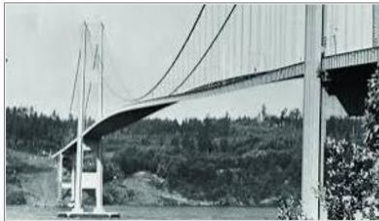
Abb.1: Torsionschwingungen der Fahrbahn der Brücke kurz vor dem Einsturz
